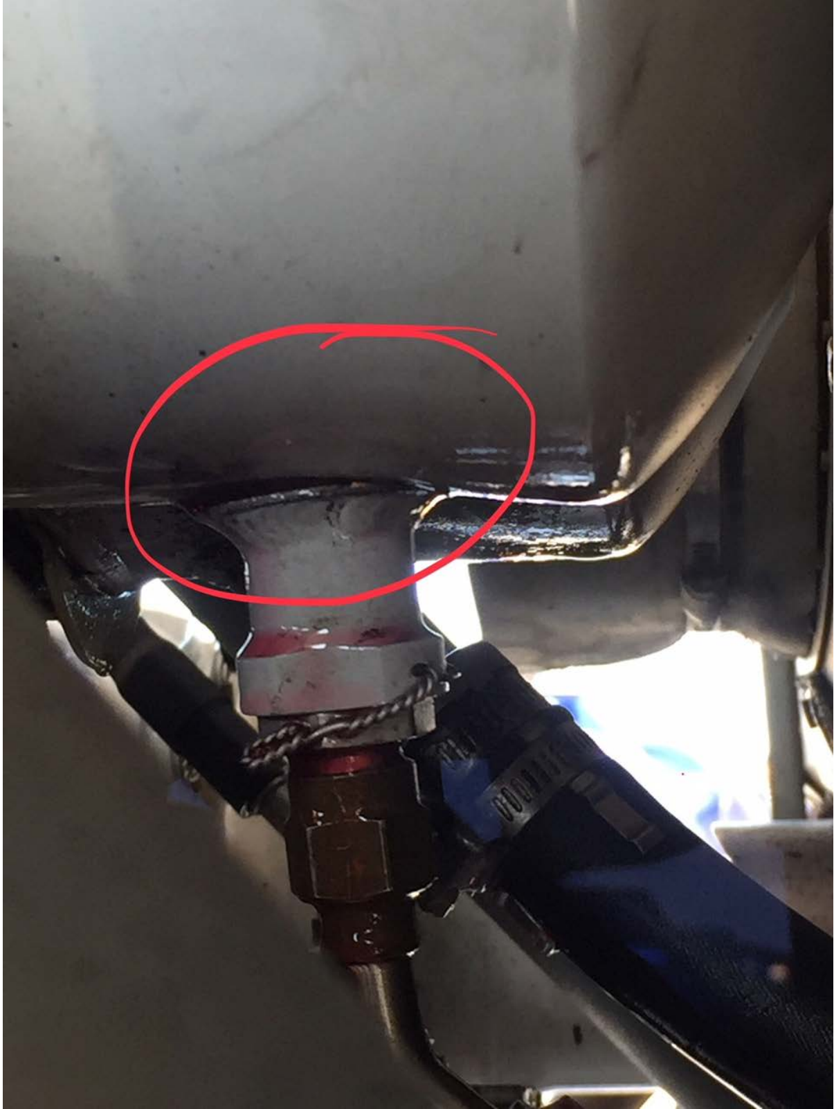
Base fissurée de la conduite d'aspiration du réservoir hydraulique
